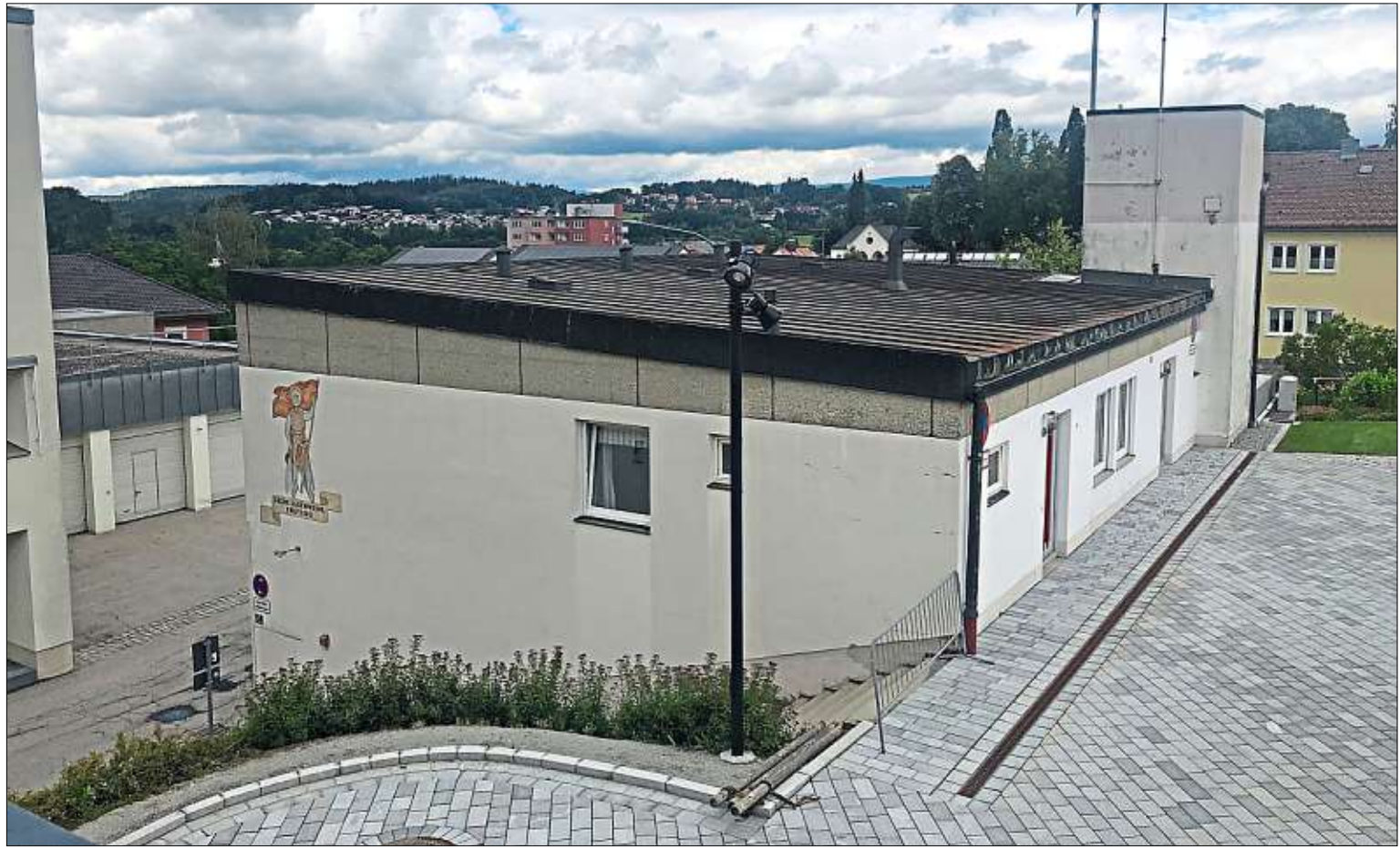
Das ehemalige Feuerwehrhaus am Rande des VMA-Innenhofs soll zu einem Übernachtungsgebäude umgestaltet werden. – Fotos: Jahns
