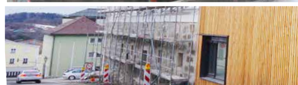
Das Übernachtungsgebäude zeigt schon sein zukünftiges Gesicht.
